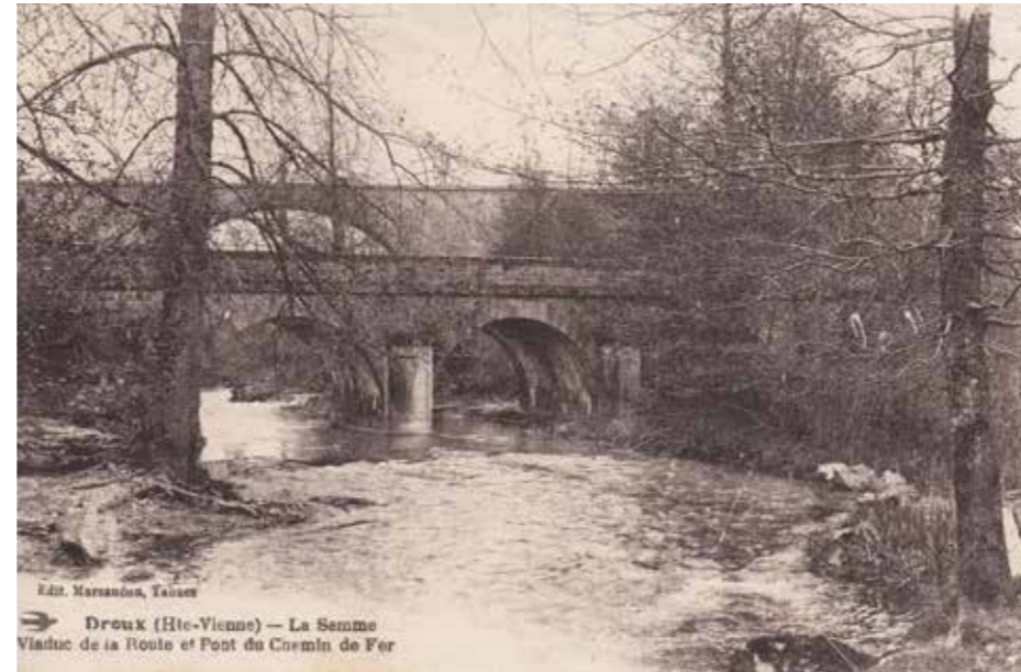
Dreux, la Semme, Viaduc de la Route et du Pont du Chemin de Fer
