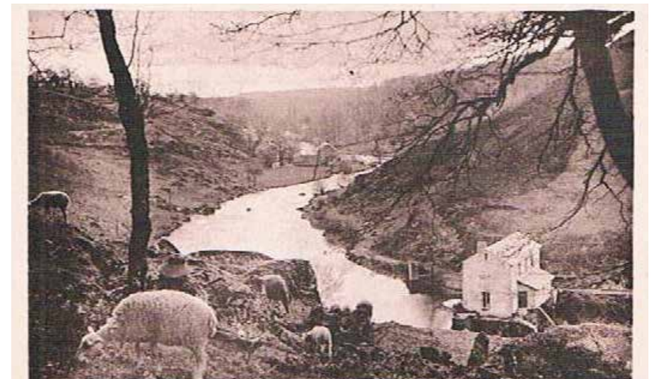
Bessines-sur-Gartempe, Usine électrique sur la Gartempe
