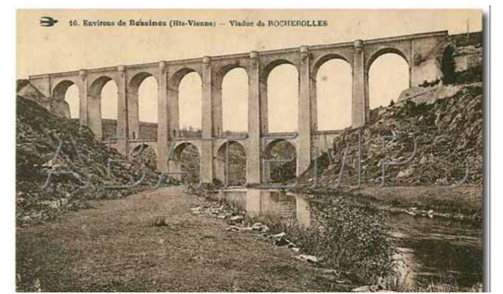
Bersac-sur-Rivalier, Viaduc de Rocherolles
